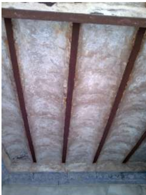
جزء من سقف احدى الغرف مثبت بالشلمان
